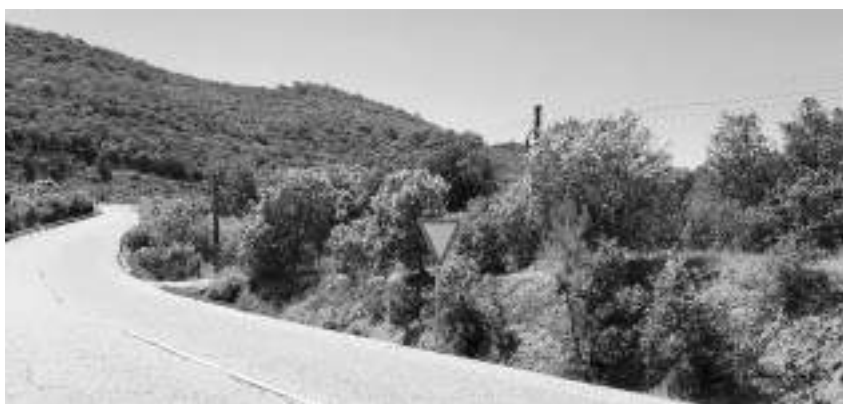
Se observa la existencia de la red de telefonía en tendido aéreo sobre postes
