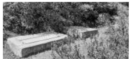
Estación depuradora de aguas residuales (EDAR) en la margen derecha de la carretera A-3176
