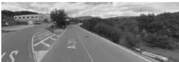
En la esquina inferior derecha se observa la ubicación de la EDAR del Polígono Industrial La Nava
