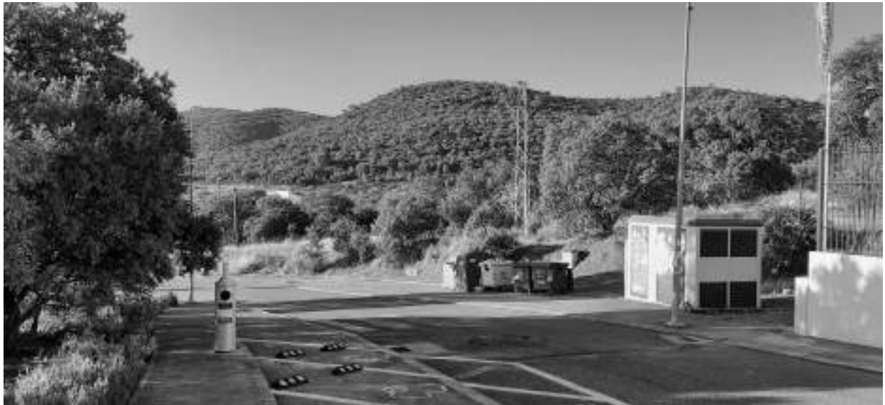
A la derecha se observa el centro de transformación del Polígono Industrial y el poste eléctrico de la línea aérea que cruza por encima de la carretera A-3176 desde la línea de 20kV que discurre junto a su margen derecha
